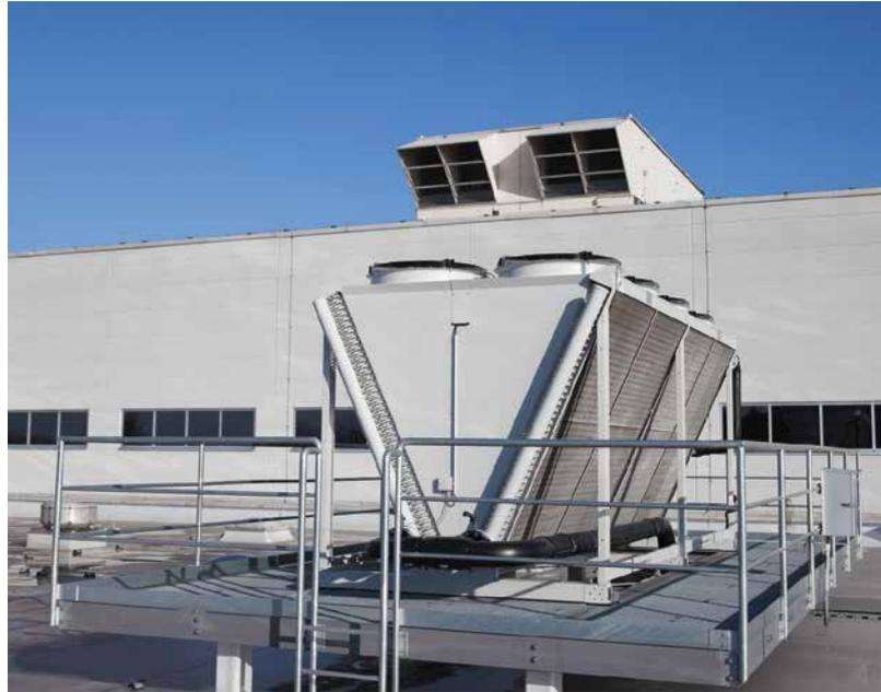
*Über den Freikühler auf dem Dach können die Kunststoffspritzmaschinen des Werks in Neustadt an der Donau vollständig gekühlt werden.*
